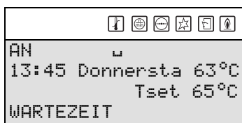
Abbildung 7.8 Frostschutz wird eingeschaltet
